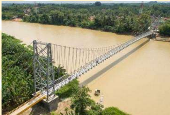
Gambar 2.2 Jembatan Gantung. Sumber: Google 2020
