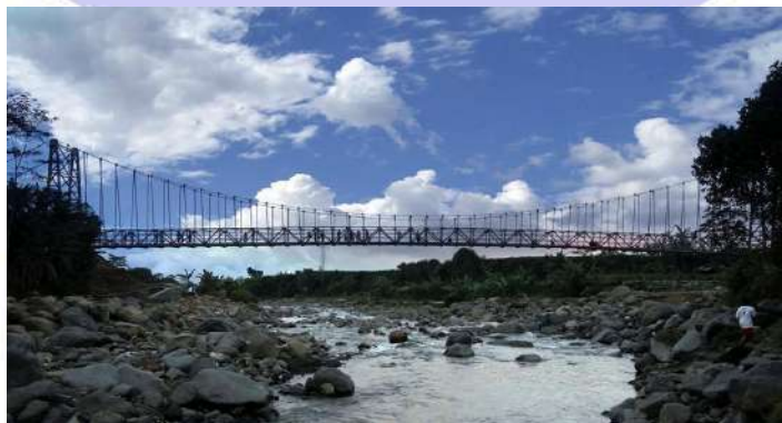
Gambar 2.1 Jembatan. Sumber: Google 2020
